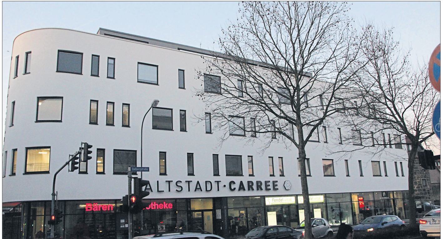
Ein Vorzeigebauwerk der Firma Schreiber ist das Fuldaer Altstadt-Carree.
